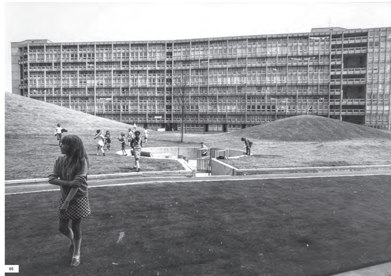
05 Robin Hood Gardens in London (1968-1972) steht exemplarisch für ein gescheitertes Laubengangprojekt der 1970er-Jahre. Im Jahr 2018 wurde es vollständig rückgebaut. FOTO: Sandra Lousada
